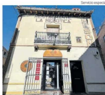
La Rebotica ha cambiado sus ventanas y puertas.
